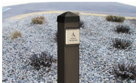
ADA Door Opening Access
