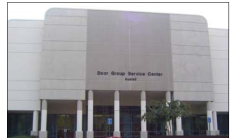
Door Group Service Center - Austell
